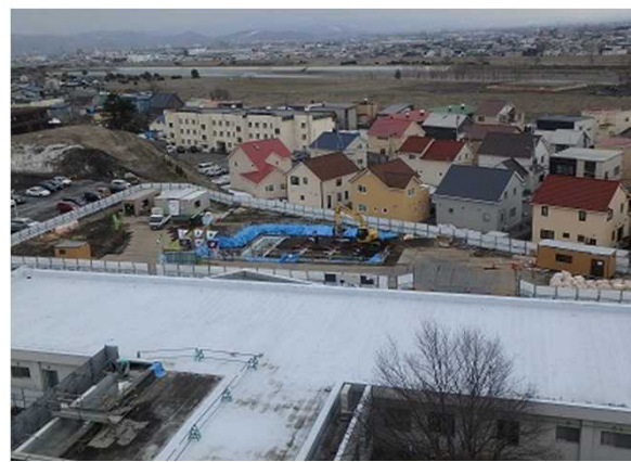
受水槽、液酸ポンプ棟(中央奥)の建設が始まりました
