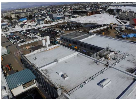
リハビリ棟(中央)の解体が始まりました
